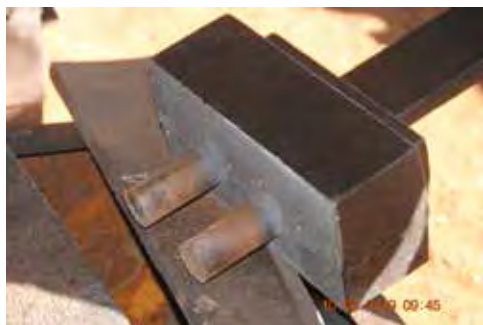
Detail podstavca s armatúrou repliky náhrobného kríža. Foto: Ing. Miroslav Mičianik
